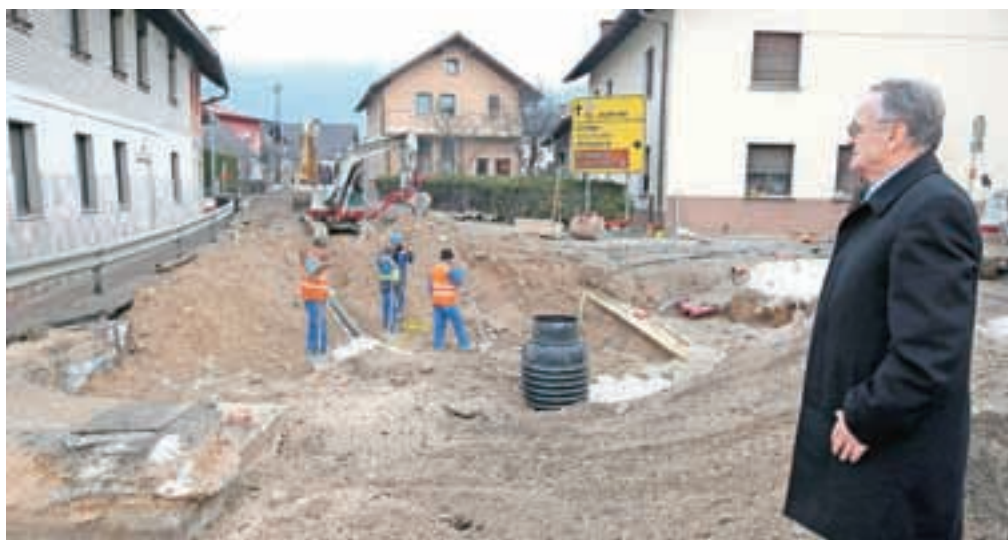
Šenčurski župan Ciril Kozjek si je prejšnji teden tudi osebno ogledal potek gradbenih del na Visokem. / Foto: Gorazd Kavčič
