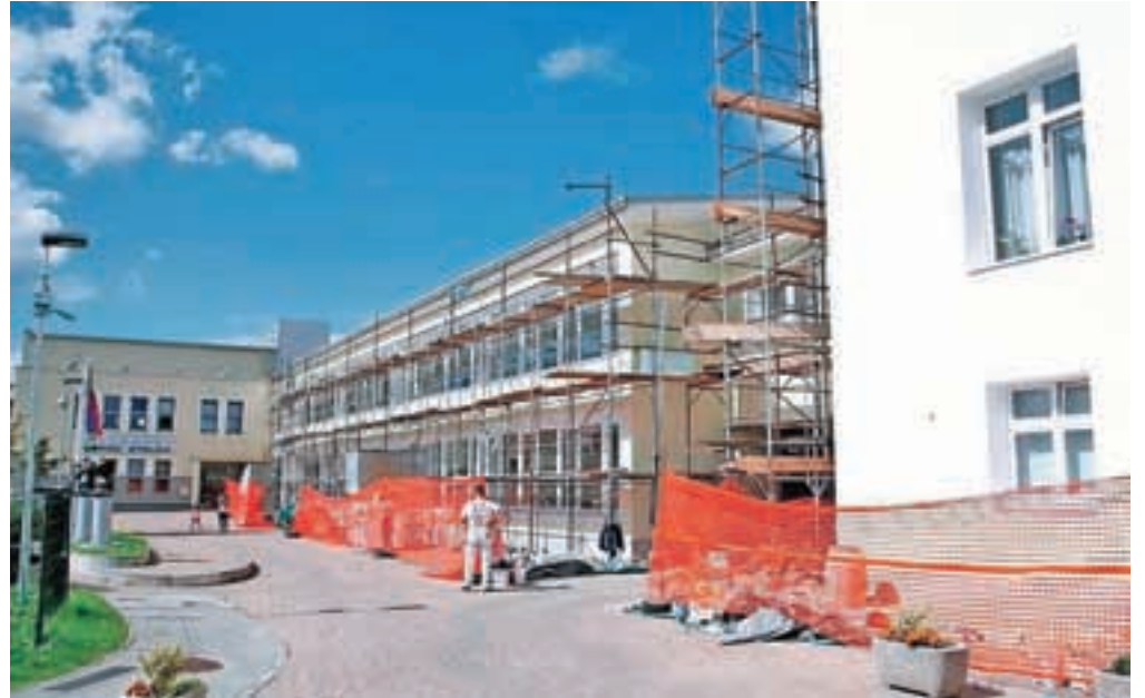
Velika investicija, ki so jo prav tako že začeli lani, je tudi prenova žirovniške šole, ki jo bodo povečali in nadgradili z novo šolsko jedilnico in dodatnimi učilnicami.
