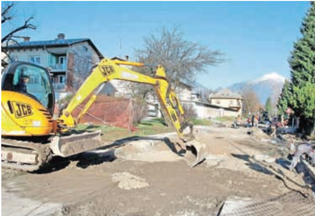
Dela pri gradnji vodovoda potekajo po načrtih. / Foto: Gorazd Kavčič
