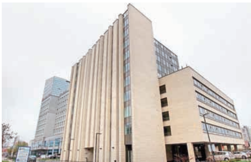
Gorenjska banka je kreditirala gradnjo Dunajske vertikale, zdaj pa je kot največja ločitvena upnica v stečajnem postopku na dražbi kupila celotni kompleks z izjemo štirih stanovanj, ki so bila prodana že prej. / Foto: TK
