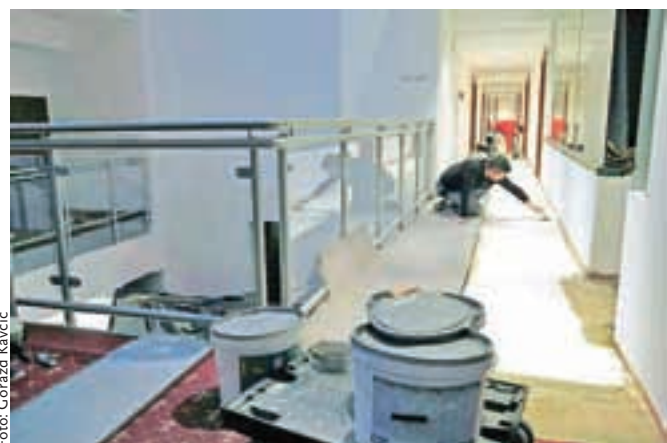
V hotelu Kompas ta čas poteka temeljita obnova.
