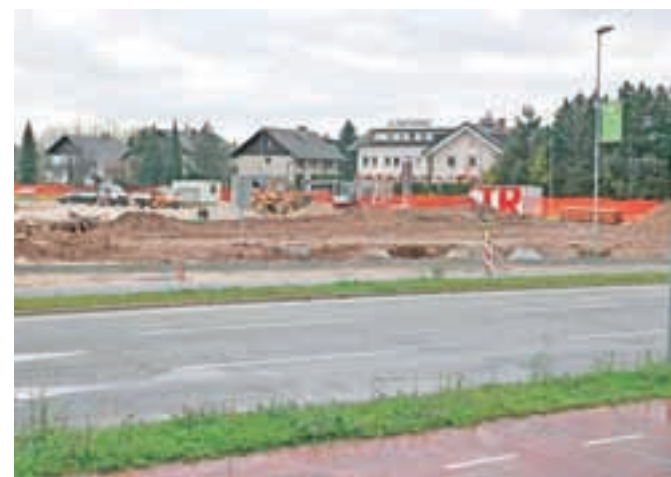
Dela pri gradnji nove poslovalnice trgovine Hofer so se že začela. / Foto: Gorazd Kavčič
