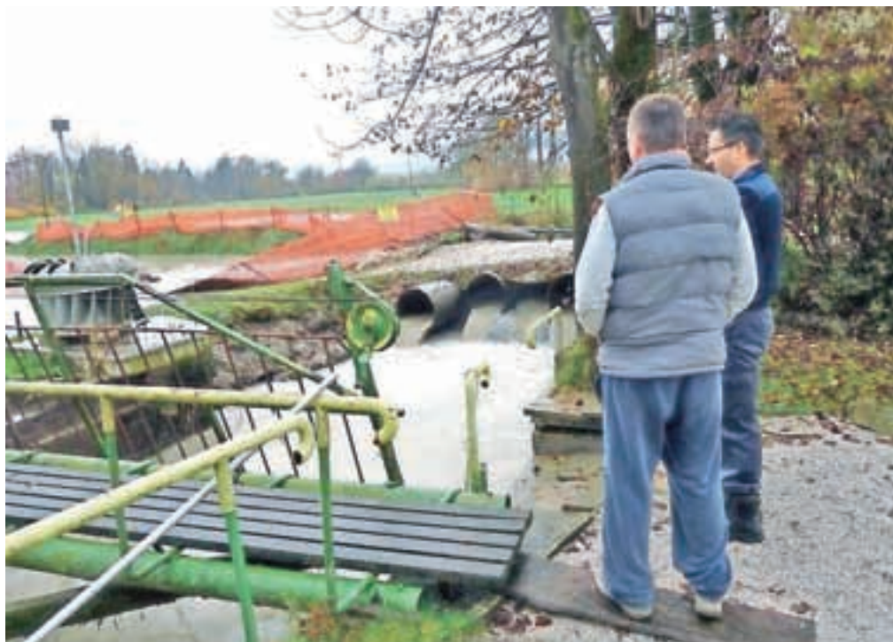
Posledica prebitega nasipa v Volčjem Potoku je bilo poplavljenno območje pri mali hidroelektrarni na Hudem, kjer poteka tudi gradnja plinovoda.
