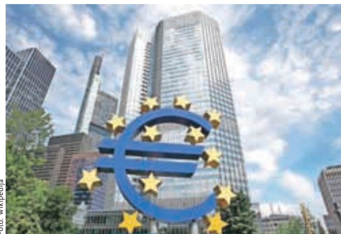
Evropska finančna katedrala v Frankfurtu, sedež ECB; to je stara stavba, letos so zgradili novo, še dražjo.
