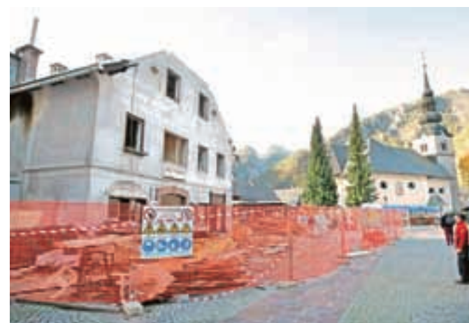
Stari Ljudski dom bodo porušili. Že do začetka zime naj bi bila na njegovem mestu pod streho nova stavba.
