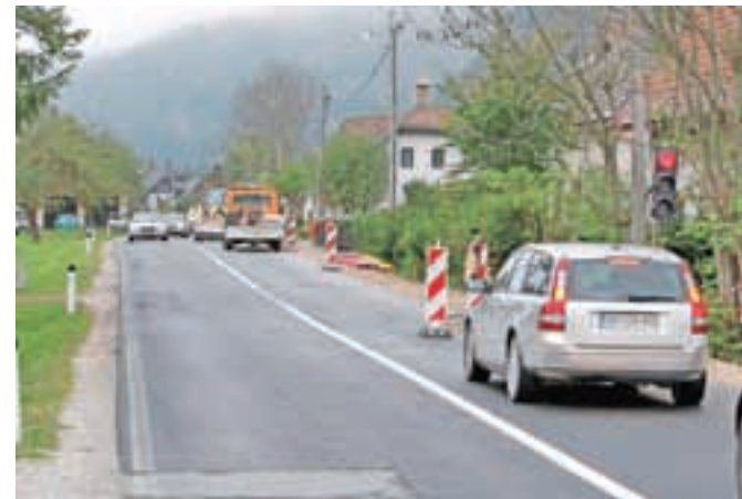
Od mostu čez Savo do gostilne Jožica bo pločnik urejen po desni strani cestišča, od tam naprej do gasilnega doma pa po levi strani. / Foto: Gorazd Kavčič
