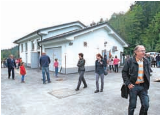
V čistilno napravo se stekajo odpadne vode iz Kroke in okoliških vasi, kasneje bo nanje priključena tudi Kamna Gorica. / Foto: Gorazd Kavčič
