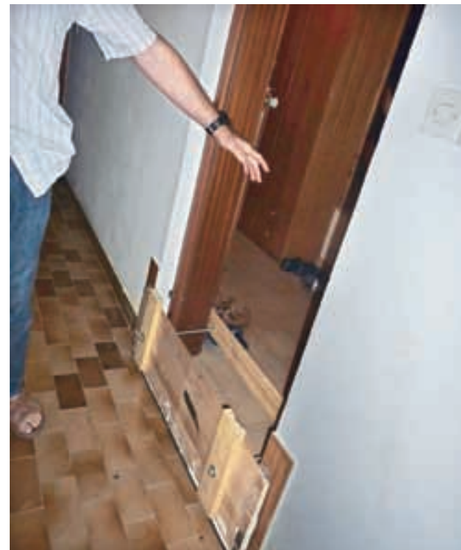
Stanovanjci so izdelali posebne spodaj zatesnjene pregrade za vrata, ki onemogočajo vdor vode v prostore.
