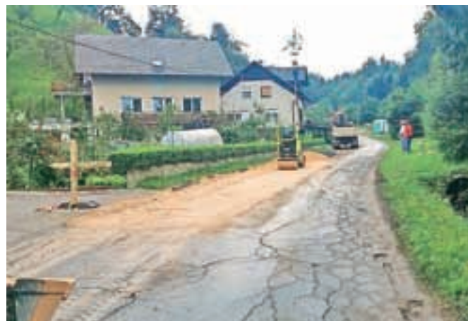
Gradnja kanalizacije v Tunjiški Mlaki
