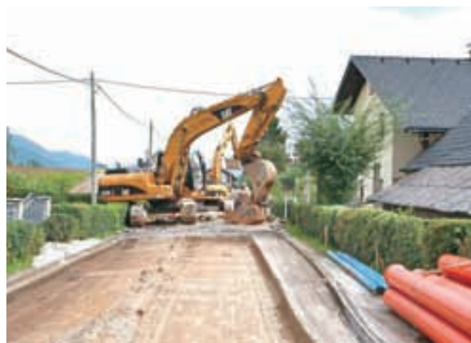
Gradnja kanalizacije na Visokem / Foto: Gorazd Kavčič
