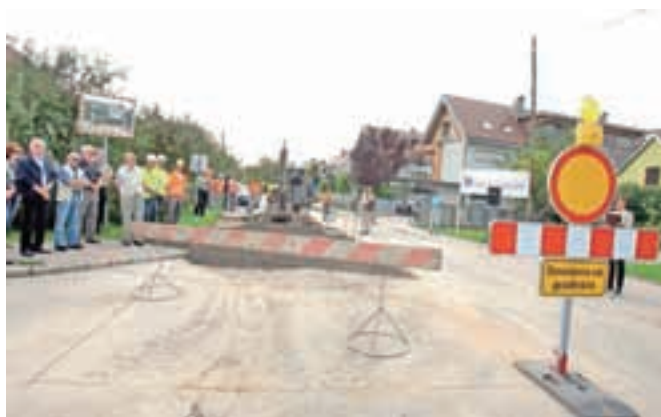
Obnovili bodo vodovod, uredili meteorno in fekalno kanalizacijo ter novo javno razsvetlavo, zgradili pločnik, kjer ga še ni ... Foto: Tina Dokl
