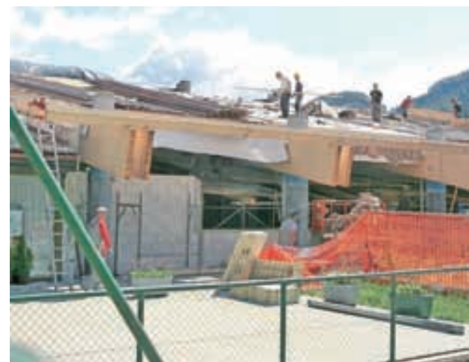
Obnovitvena dela na plavalnem bazenu v Železnikih potekajo že vse od maja. / Foto: Tina Dokl
