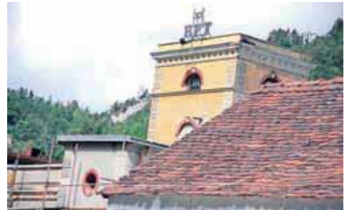
Za enega od imenitnih umetnih slovenskih otokov slovi območje nekdanjega BPT. Bolj malo pa je ostalo arhitekturne vrednosti, saj je večina objektov zapuščen in propadajo. / Foto: Tina Dokl
