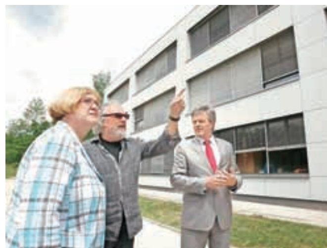
Prejšnji teden so končali energetska sanacijo radovljiške osnovne šole – na fotografiji so župan Ciril Globočnik, ravnateljica Zlata Rejc in arhitekt Marko Smrekar; zdaj začnejo sanacijo osnovne šole v Lescah. / Foto: Gorazd Kavčič
