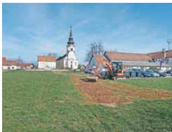
Arheologi so prva izkopavanja na mestu bodočega središča Vodice že opravili, a v prihodnjih mesecih se bodo še vrnili. Našli so namreč ostanke iz rimske dobe.
