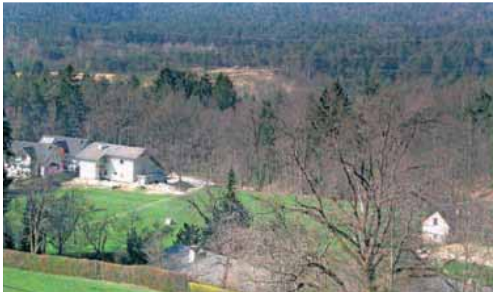
Pogled z južne poti na Šmarjetno goro na poseko (pogled za hišo), kjer je v načrtih stanovanjsko naselje Pševno II. Gradijo še ne, saj tako kot v bližnji industrijski coni Laze tudi tu območje še ni komunalno urejeno.
