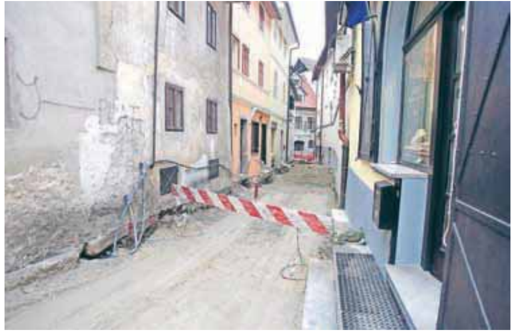
V Škofji Loki nadaljujejo obnovo ulic.
