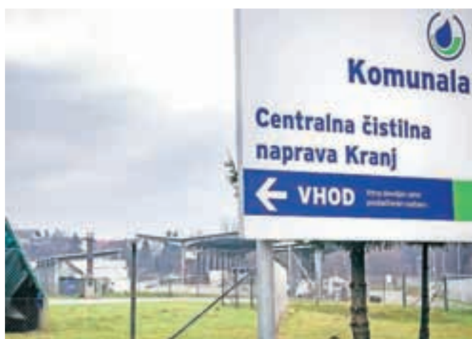
Obstoječo centralno čistilno napravo na Zarici, ki ima obratovalno dovoljenje še do konca leta, bodo morali vzdrževati do graditve nove. / Foto: Primož Pičulin
