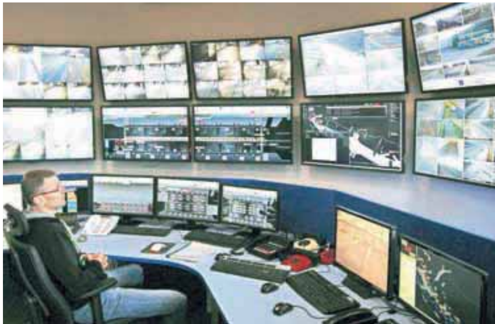
Nadzornik v nadzornem centru na Hrušici ima odslej olajšano spremljanje dogajanja v predoru, saj mu sistem samodejno javi morebitne izredne dogodke. / Foto: Gorazd Kavčič
