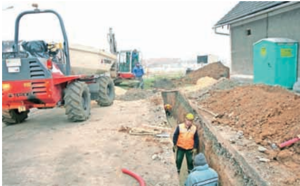
V občini trenutno celovito komunalno urejajo vzhodni del: na sliki dela na vodovodnem omrežju na območju Godešiča in Reteč. /Foto: Tina Dokl
