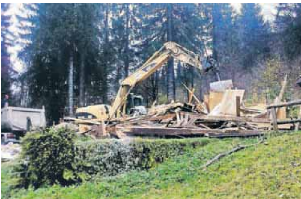
Med rušenjem Kuzmičeve hiše ob Bohinjskem jezeru
