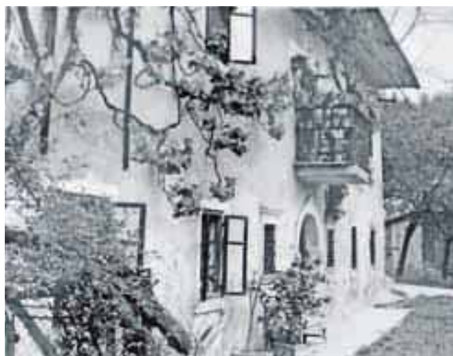
Stanje stavbe pred obnovo leta 1976 / Foto: arhiv družine Mauser
