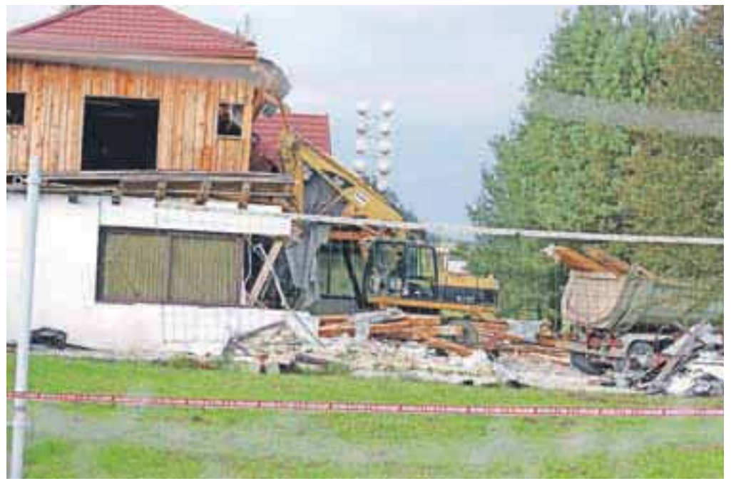
Čeprav so gradbene stroje na Povodje pripeljali že v torek, so rušenje začeli šele naslednj dan. / Foto: Tina Dokl
