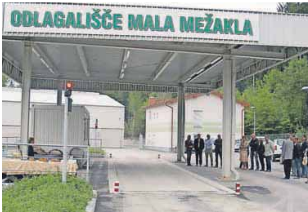
Na deponiji so zgradili novi vstopni plato s tehtnico, v ozadju nova upravna stavba.
