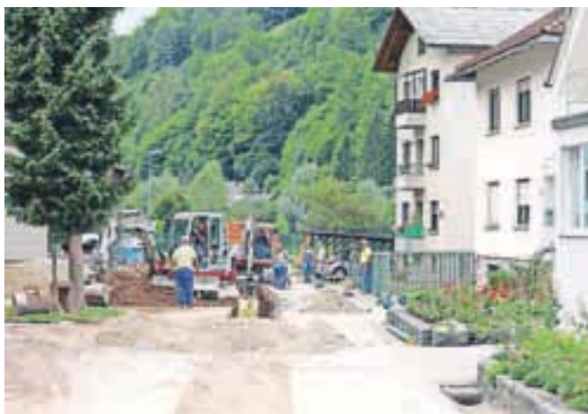
Gradnja vodovoda mimo šole bo zaključena v teh dneh, celotna dela do konca oktobra. / Foto: Denis Bozovičar
