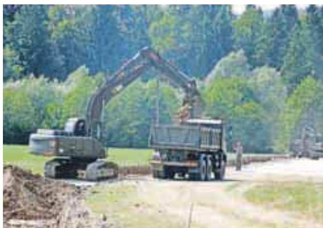
Začeli so obnavljati cesto mimo strelišča v Crngrobu.
