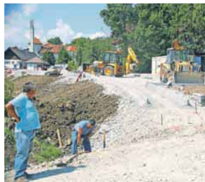
Še zadnja dela na dovozni cesti proti Domu starejših občanov Preddvor / Foto: Tina Dokl
