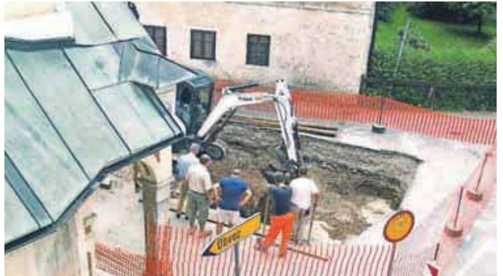
V Stari Loki so med gradnjo kanalizacije našli na srednjeveški vodnjak. / Foto: Klemen Karlin
