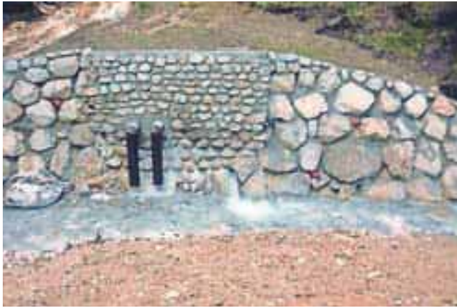
Novozgrajeno zajetje naj bi rešilo težave s pomanjkanjem pitne vode v sušnih obdobjih. / Foto: arhiv Občine Žirovnica
