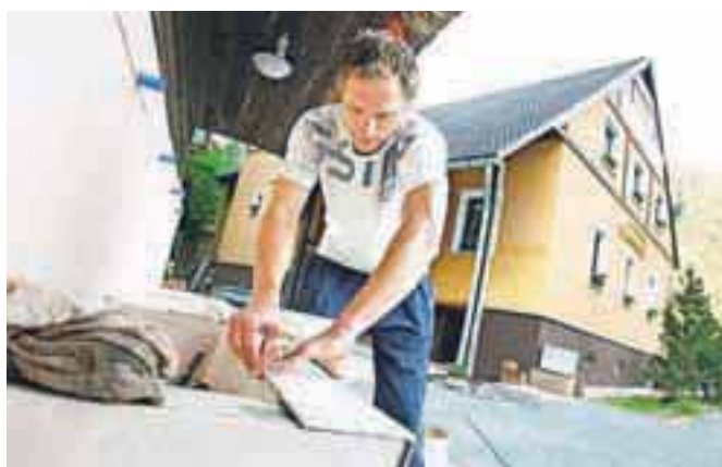
Še zadnja dela pri zunanjih sanitarijah / Foto: Gorazd Kavčič
