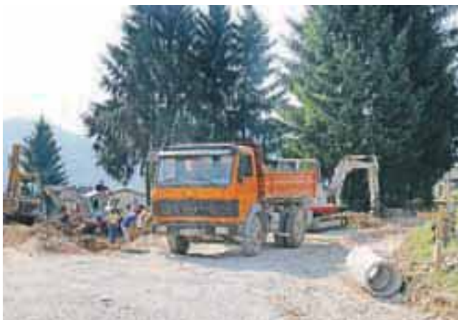
Ob šoli v Pirničah so začeli graditi nov vrtec. / Foto: Tina Dokl
