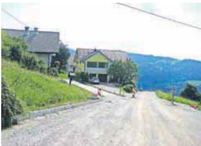
V vaseh pod Starim vrhom morajo gradbinci le še položiti asfalt na lokalno cesto.
