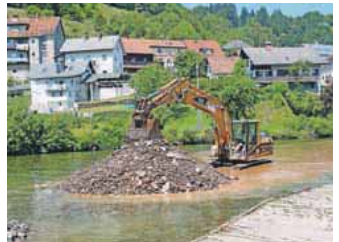
Poglobili so strugo kopaljšča v Puštalu. / Foto: Valentin Jesenovec
