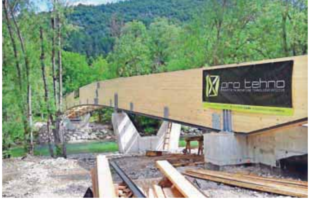
Kolesarski most v gradnji; most je večinoma izdelan iz lesa in krit s skodlami.
