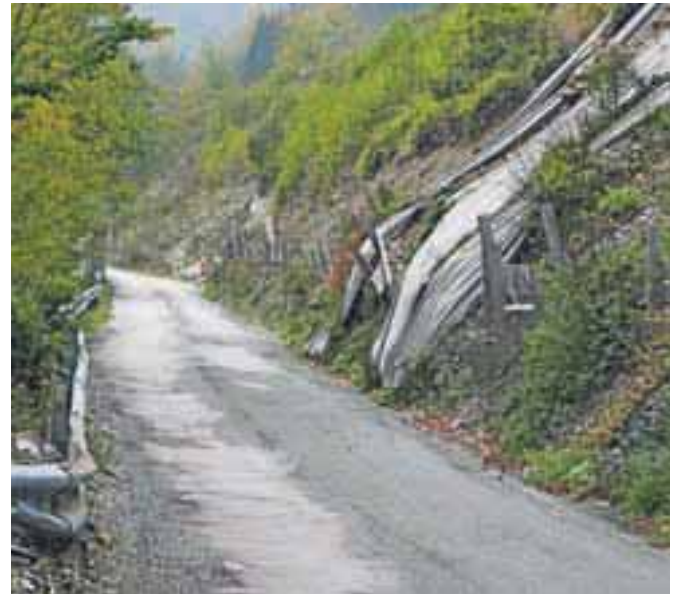
Letos in prihodnje leto bodo obnovili štiristo metrov ceste v Sorico.
