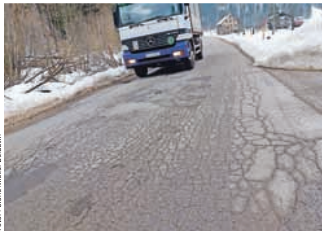
Žirovci že dolgo opozarjajo na katastrofalno stanje ceste proti Logatcu. Več mesecev zaprt promet za tovornjake pa je za domače gospodarstvo še hujša katastrofa.
