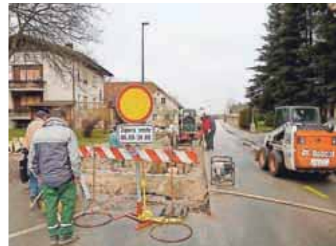
Glavarjeva cesta v Komendi bo zaradi gradnje kanalizacije predvidoma do začetka maja zaprta za promet.
