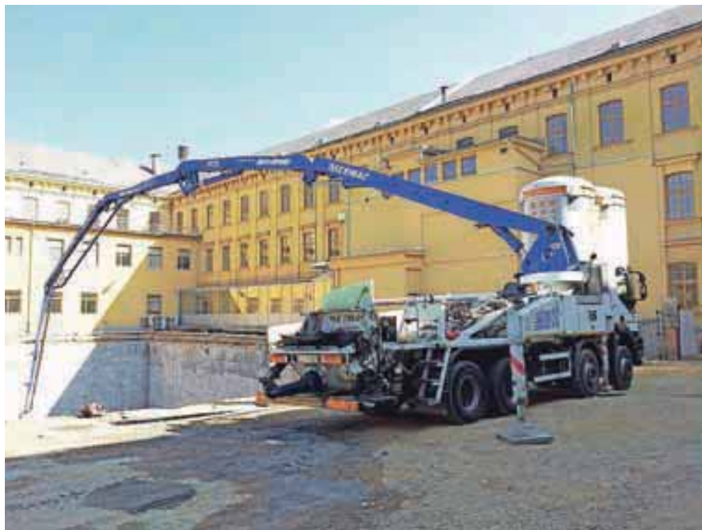
Marolt Beton ima v lasti tudi 41-metrске črpalke.
