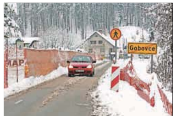
Rekonstrukcijo mostu čez Savo v Podnartu so začasno prekinili. / Foto: Gorazd Kavčič
