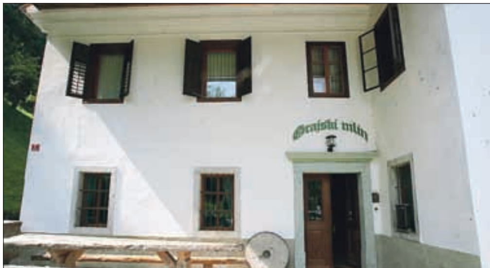
V Grajskem mlinu se tudi letos bojijo zmrzali, saj so vodovodne cevi po enem letu še vedno odkopane.
