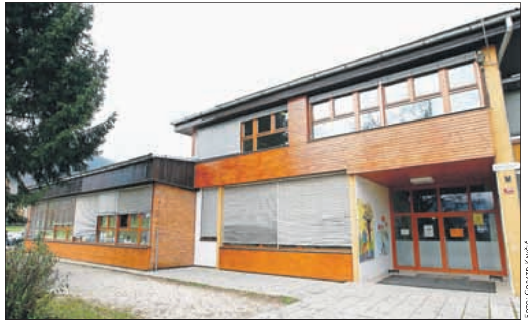
V Osnovni šoli Gorje so energetske učinkovitost povečali tudi z zamenjavo oken.
