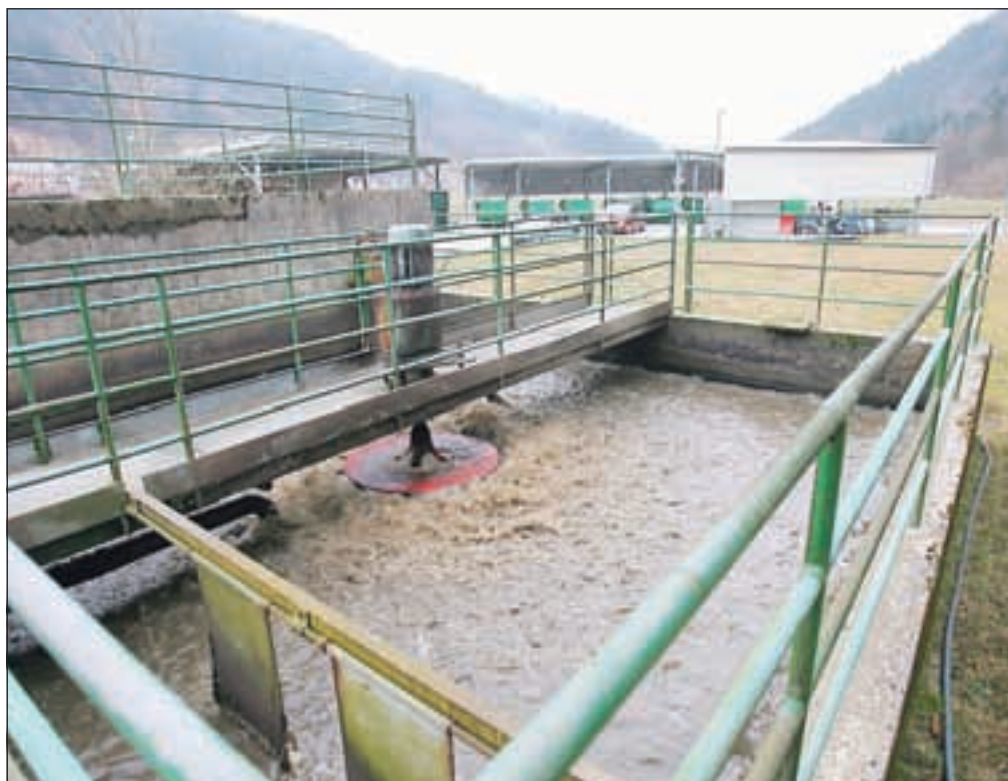
V Železnikih bo prihodnje leto največji projekt rekonstrukcija čistilne naprave. / Foto: Tina Dokl
