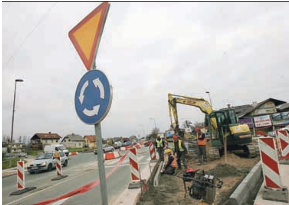
Ta teden so začeli z gradnjo na Starem Dvoru, kjer bo iz nekdanjega križišča nastalo montažno krožišče. / Foto: Tina Dokl
