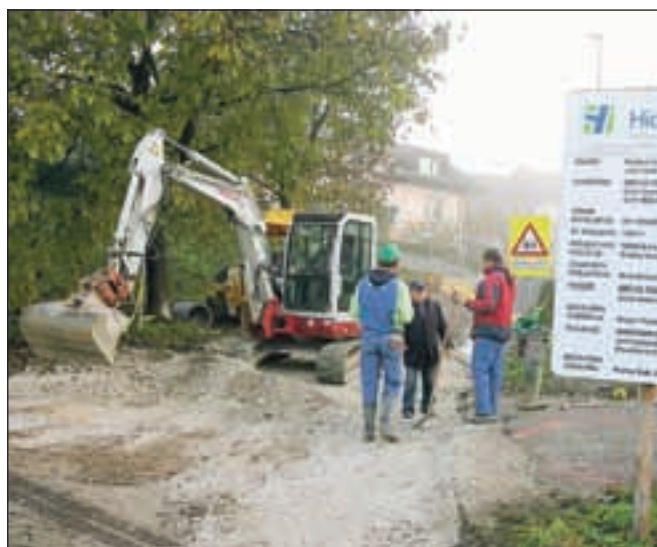
V Zgornjih Pirničah gradijo kanalizacijo. / Foto: Tina Dokl
