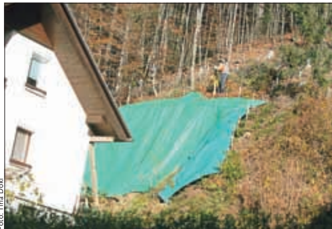
Interventna sanacija je zasilno ukrotila plaz nad hišo v Dašnici.
