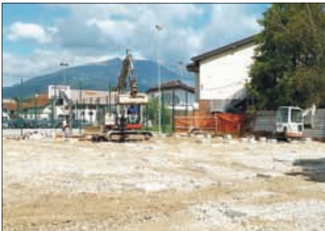
Temelji za modularni vrtec so že postavljeni.
