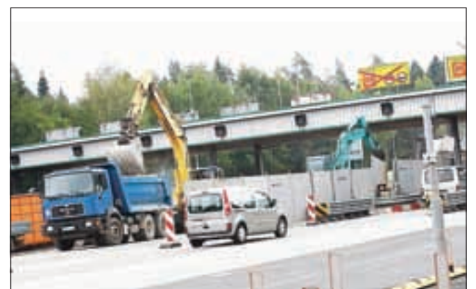
Rušitvena in obnovitvena dela na Torovem izvaja Gorenjska gradbena družba. / Foto: Gorazd Kavčič
