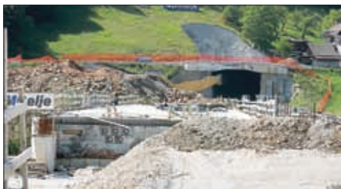
Gradbišče pri predoru pod Stenom že nekaj časa miruje.
