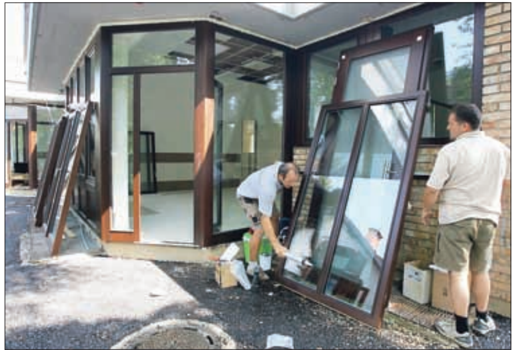
V vrtcu Janina v Kranju potekajo obnovitvena dela. / Foto: Tina Dokl
