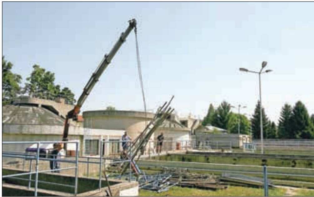
Začela se je že temeljita obnova in nadgradnja centralne čistilne naprave na Suhi. / Foto: Tina Dokl
