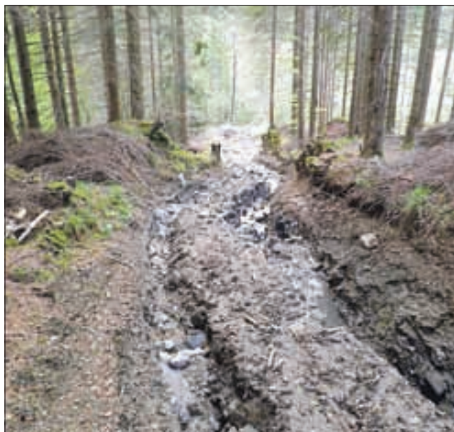
Posek in spravilo lesa sta potekala s težkimi stroji na način, ki je bolj primeren za golosečni način sečnje, ugotavlja Andrej Avsenek in dodaja, da so posledica tega tudi preširoke in poškodovane gozdne ceste.
