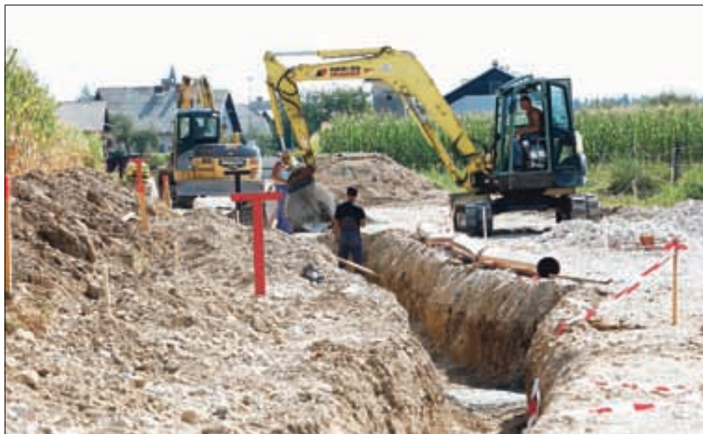
Gorenjsko gradbeno podjetje izvaja rekonstrukcijo občinske ceste tudi med Voklim in Vogljami. / Foto: Gorazd Kavčič
