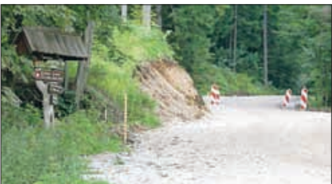
V času sanacije je cesta delno zaprta. / Foto: Tina Dokl
