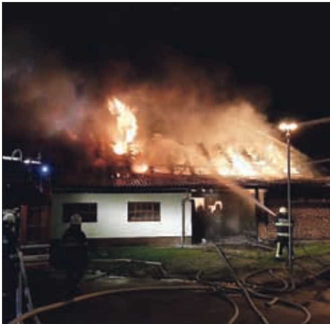
Ko so prvi gasilci prispeli na kraj požara, je ogenj že prebil ostrešje. / Foto: GZ Radovljica
