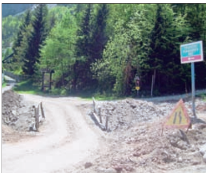
Na platoju mejnega prehoda Ljubelj, na cesti do naselja Sv. Ana, hotela Garni in parkirnega prostora pod njim so začeli obnavljati dotrajan most čez hudournik z Zelenice. Sanacija zajema obnovo nosilne konstrukcije in vozne površine ter ograjo mostu in bo stala 37 tisoč evrov.
