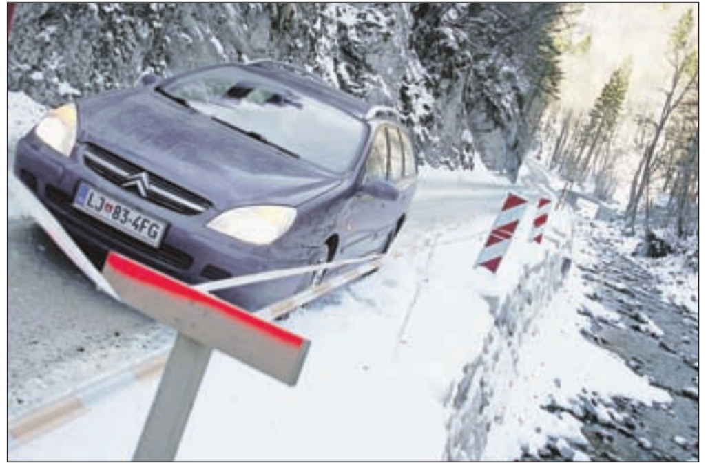
► 2. stran Zgodaj spomladi bodo končno začeli z rekonstrukcijo davške ceste. / Foto: Gorazd Kavčič
