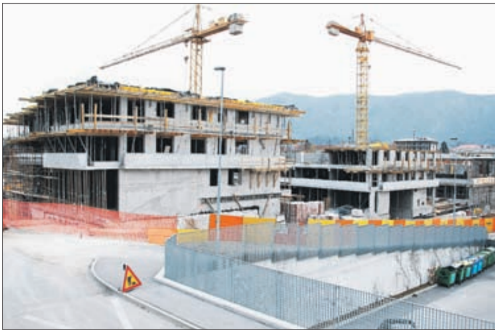
Gradbena dela na nastajajočem Vurnikovem trgu v Radovljici v zadnjih mesecih vidno napredujejo, a bo mestna knjižnica vsaj še nekaj let na stari lokaciji. / Foto: Gorazd Kavčič
