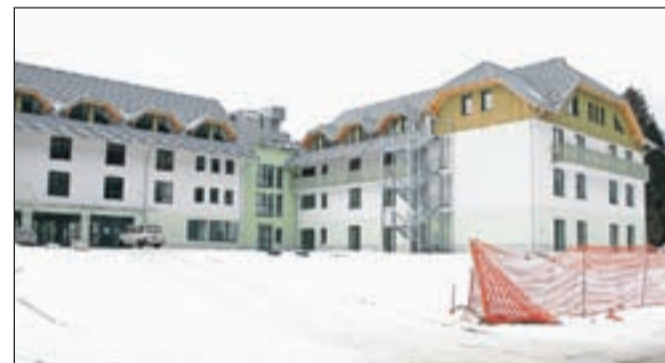
Novi dom za starejše občane v Kranjski Gori
